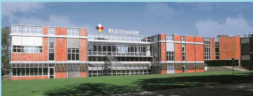
14.02.2021 und 25.02.2021, Rottendorf Pharma GmbH baut an der A2 in Oelde und investiert in Ennigerloh 45 Mio Euro in eine neue Verpackungshalle.
